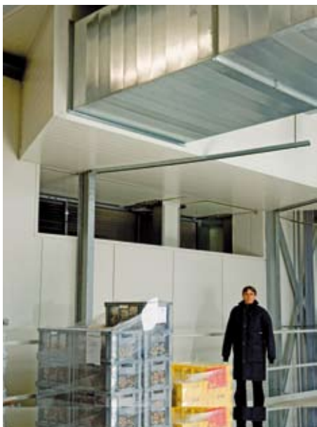
Luftansaug- und Kanalanschluss der Isolierkühler
