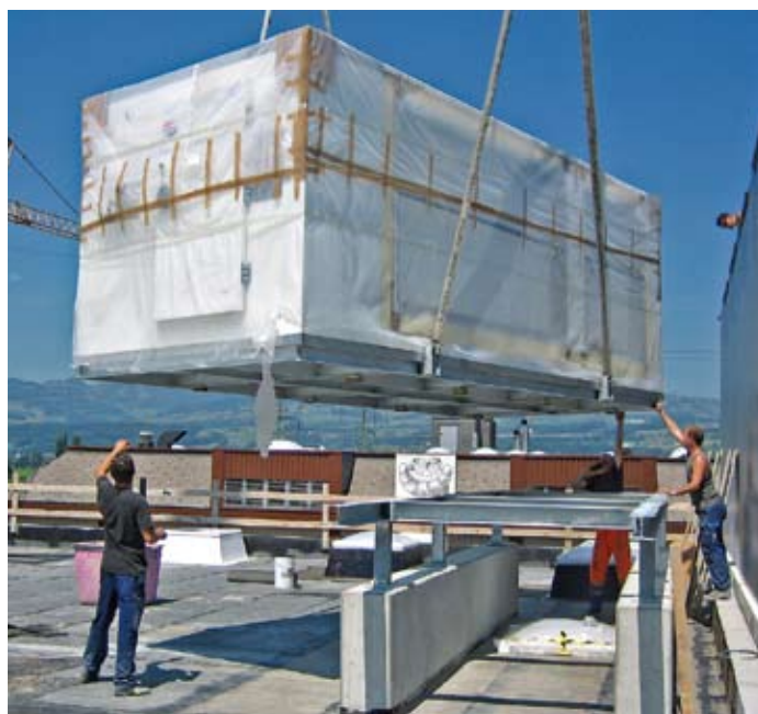
... Positionieren auf Trägerfundamenten an der Tiefkühlager-Außenwand
