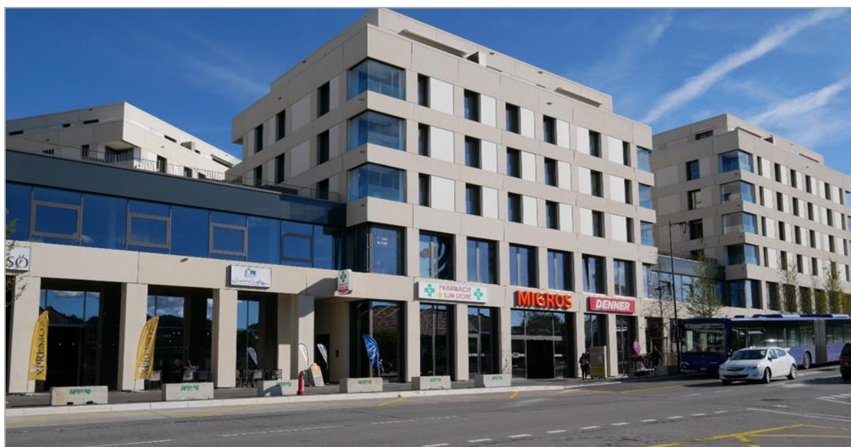
Entrée principale zone commerciale Pré-des-Comtes
