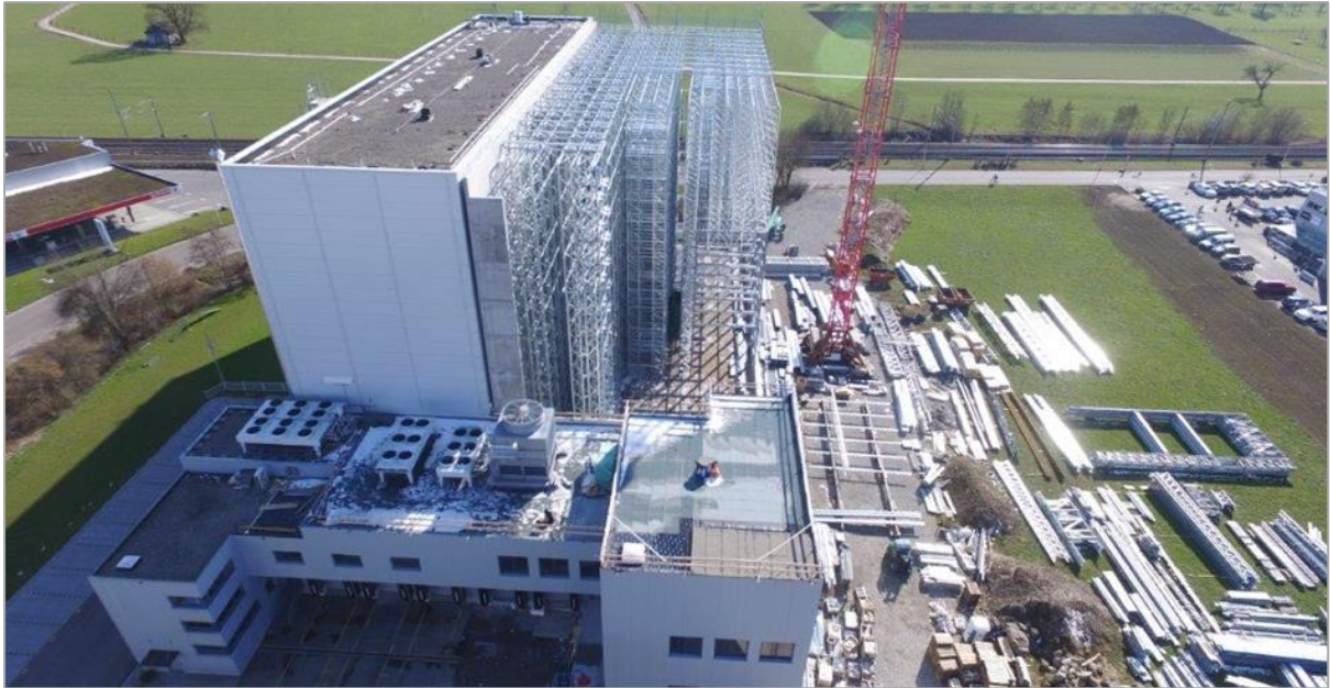
Erweiterung des Tiefkühlagers Kühlhaus Neuhof AG
