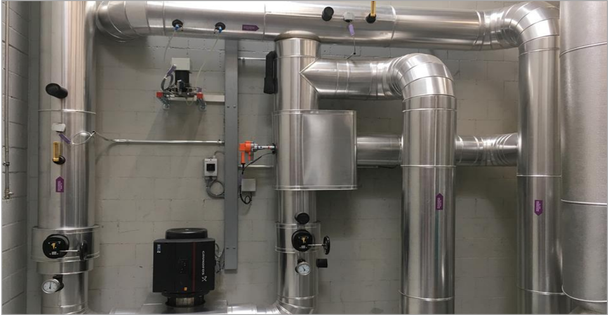
Anschluss Absorptionskälteanlage
