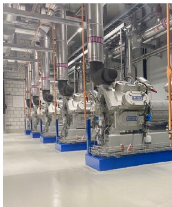
Sechs Kolbenverdichter aneinandergereiht.
